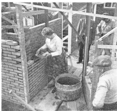
De bungalow in aanbouw.
